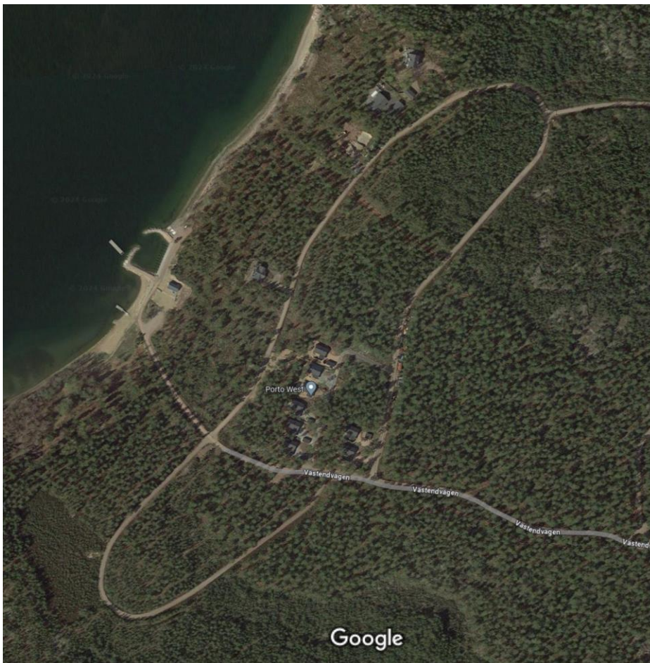
Kuva 1. Googlen satelliittikuvasta ilmenee alueen puusto ja erään vaiheen toteutettu rakentaminen. Muutama sittemmin rakennettu rakennus alueella ei vielä näy kuvassa.
