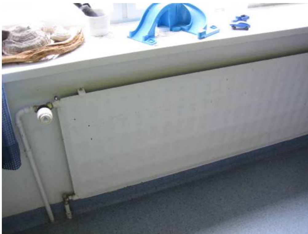
Kuva 19. Tyypillinen patteri ja esisäädettävä termostaattinen patteriventtiili.
