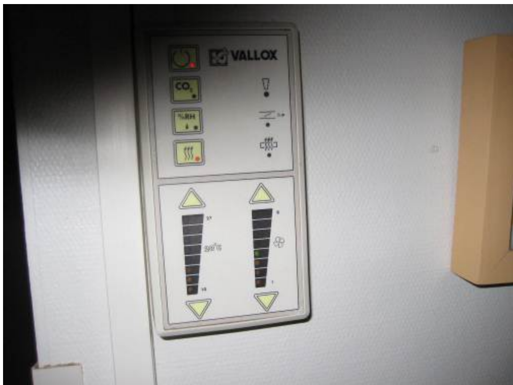
Kuva 42. Jumppasalin Vallox- IV- koneen säätöyksikkö.
