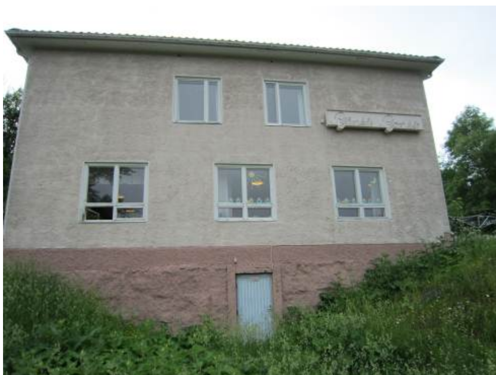
Kuvat 7 ja 8. Sisäänkäyntejä rakennuksen kellarikerrokseen. Yläkuvassa uudempi 196+-luvun autotallin sisäänkäynti ja alakuvassa alkuperäisen navetan kellarin sisäänkäynti.
