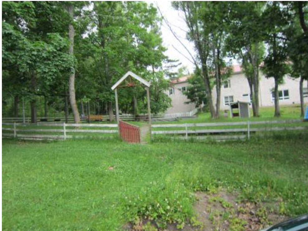
Kuva 1. Alapihalla ei ole käyttöä. Leikkipihat ovat yläpuolella. Tilarakenteita ei ole huollettu. Aita ei täytä päiväkodeille asetettuja turvallisuusvaatimuksia.
