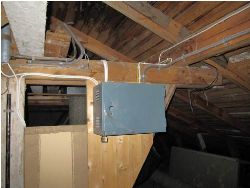
Kuva 29. Antennivahvistin ullakkotilassa.
