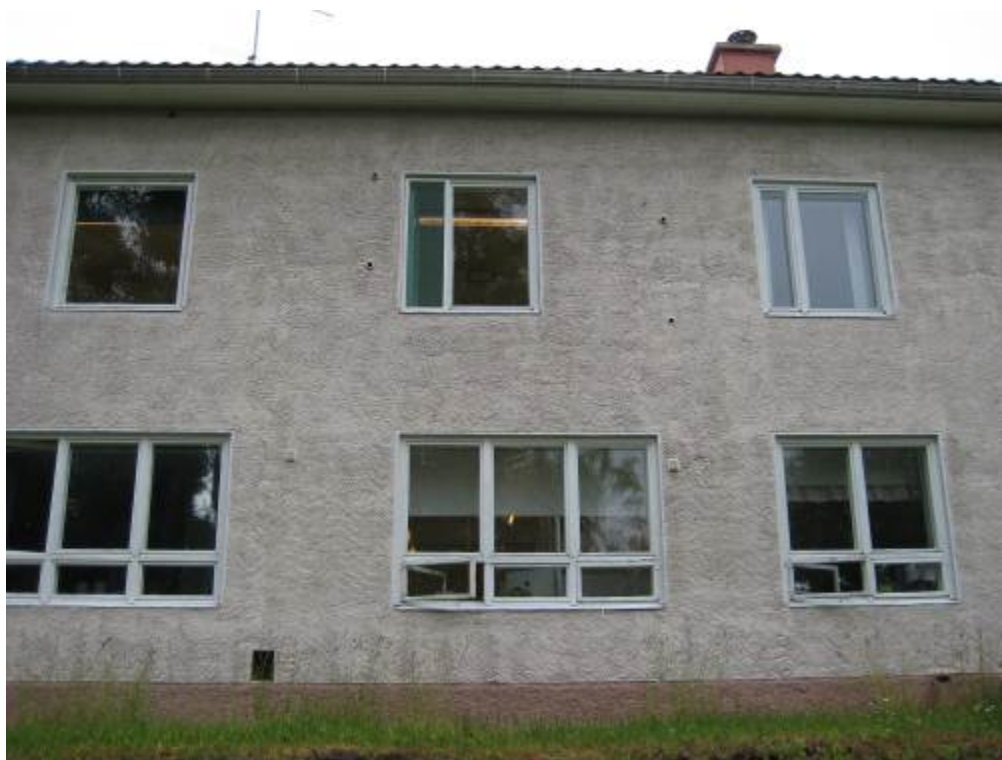
Kuva 25. Kuvassa näkyvät 1-kerroksen korvausilmaventtiilit sekä 2-kerroksen ilmeisesti vanhat käytöstä poistetut komeroiden tuuletusputket.
