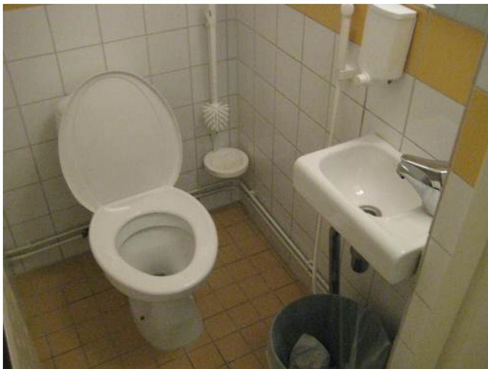
Kuva 21. Vesi- ja viemärikalusteet ovat tyydyttävässä kunnossa.
