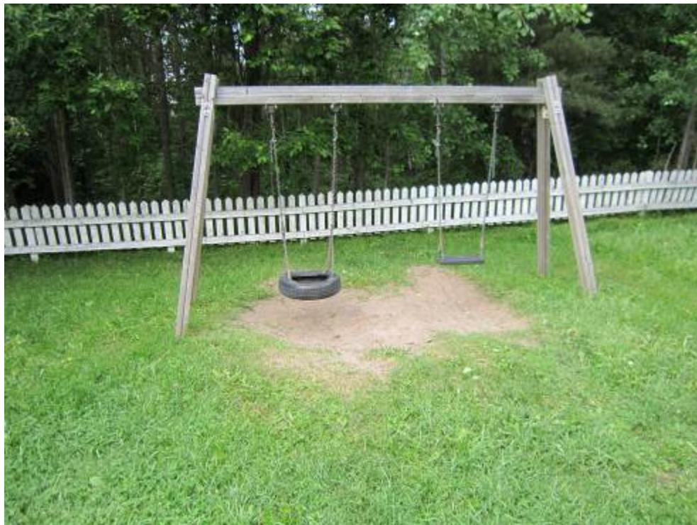
Kuva 3. Keinujen alla ei ole putoamista suojaavaa sorakerrosta tai pehmentäviä mattoja.
