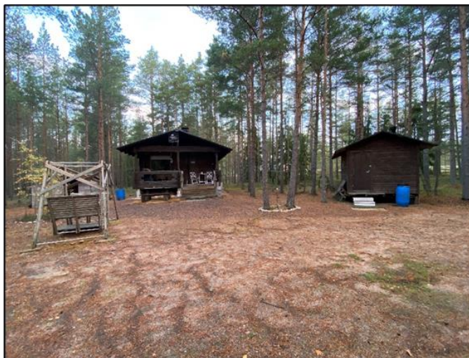
Bastu och ekonomibyggnad på inlandsskiftet A.
