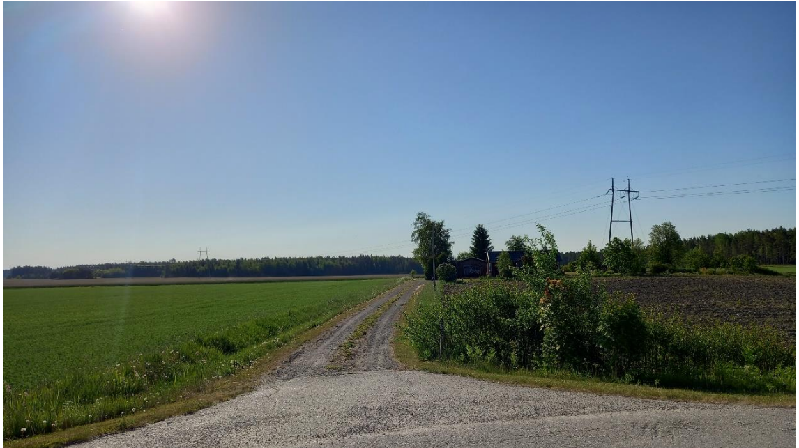
Kuva 5.6. Voimalinja erottuu vahvasti avoimessa maisematilassa etenkin siltä osin, kun se peilautuu taivasta vasten. (Kuva SW/MJ)
