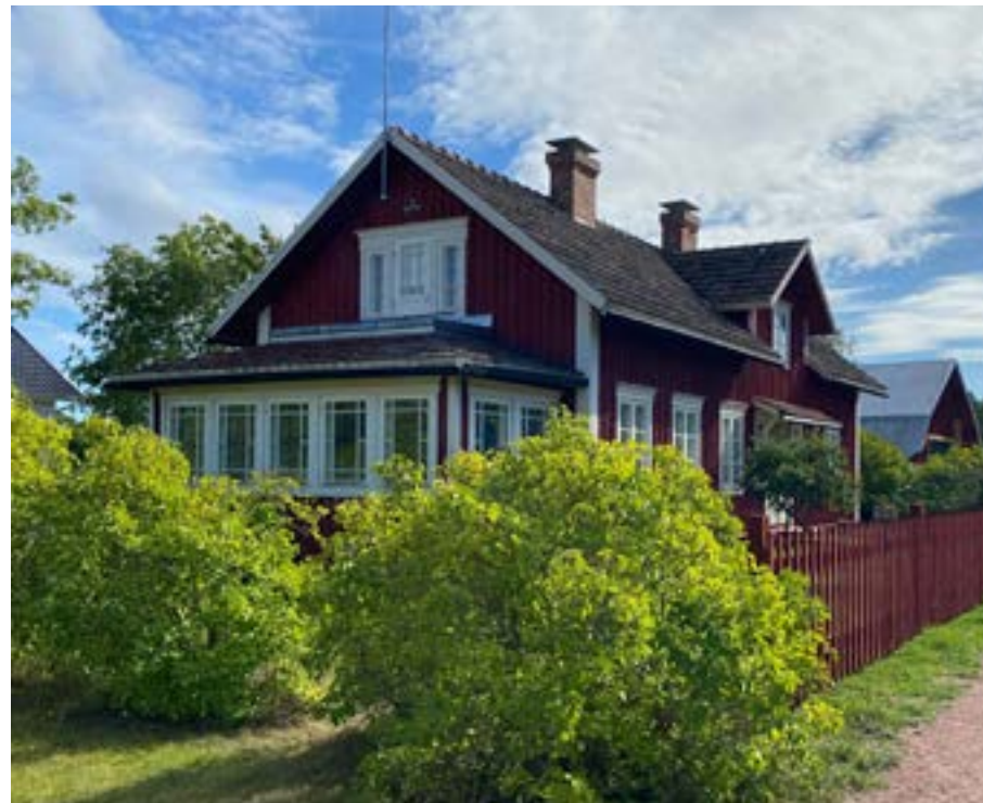
Kuva 61. Esimerkki täydennysrakentamisesta, jossa on käytetty vanhoja materiaaleja. Kuva: Tuuli Toivonen
